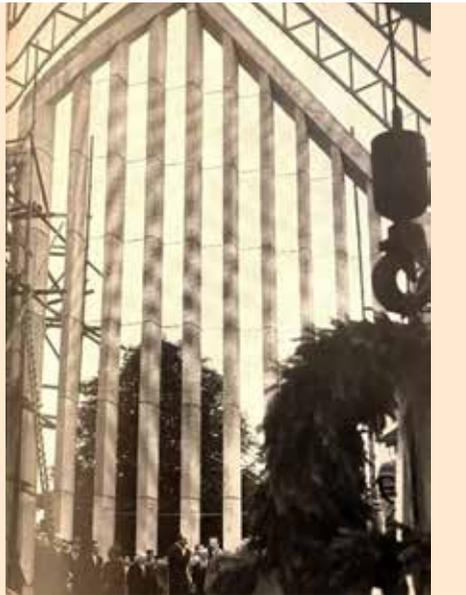
Die erste Seitenwand steht. Sie ist durch verglaste Betonfertigteile-Fenster gestaltet. Sie sind ziehharmonikaförmig versetzt und durch ein breites, geschlossenes Betonband gegliedert. Die anderen Außenwände sind in einer Stahlbetonkonstruktion mit Werksteinverkleidung ausgeführt.
